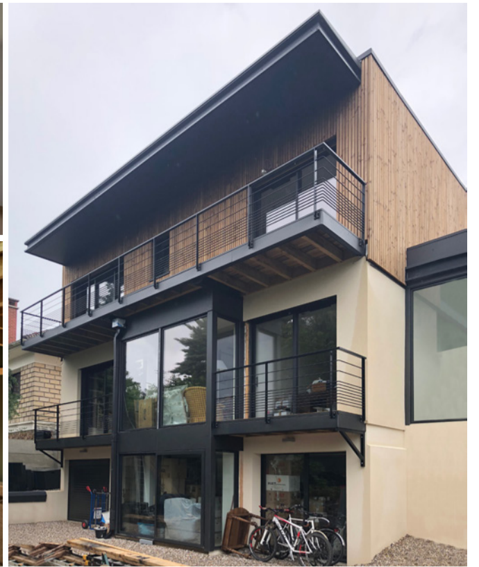
Façade sur jardin. Façade en cours d'achèvement.
