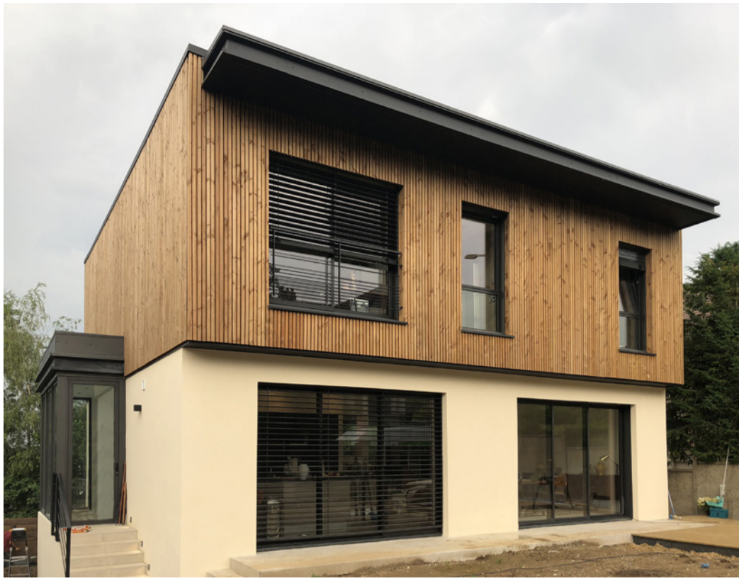
Façade sur rue. Façade en cours d'achèvement.
