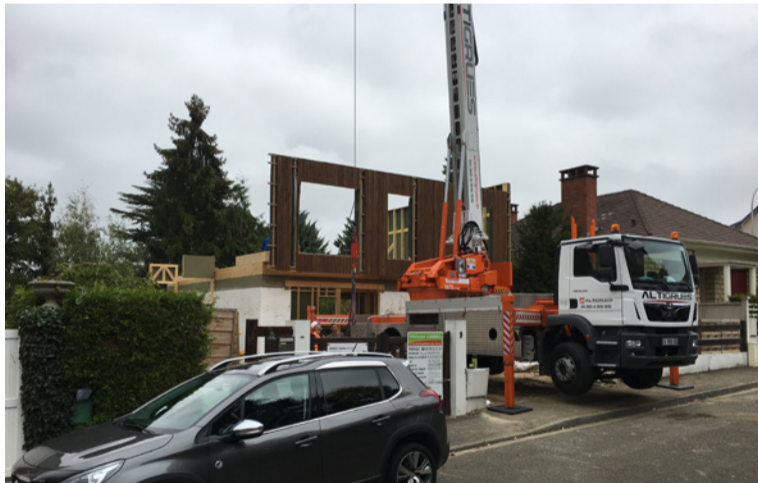
Assemblage de l'ossature bois de l'étage
